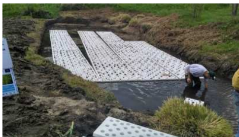
Plantación en El Arenal (Ávila) de los primeros filtros verdes flotantes para producir bioetanol
